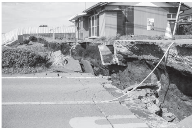
阿蘇市の被災状況
