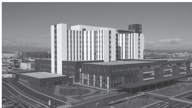
図 1. 全面移転新築となった当院
