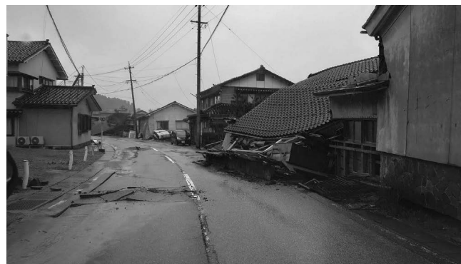
倒壊家屋があちこちで道路にせり出していた
