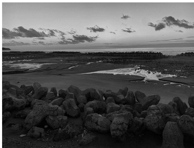
隆起によりテトラポットの海側に海面がない様子
